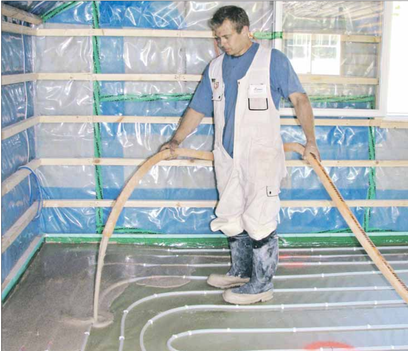
Jouni Kartaslammi sanoo, että pienyrityksen kannattaa rakennusallalla pitää montaa rautaa tulla ja laajentaa osaamistaan. Itse hän tekee sähkötyötä lukuun ottamatta melkein mitä tahansa rakentamiseen liittyvää. Kuva: JoKa-Remontit.
