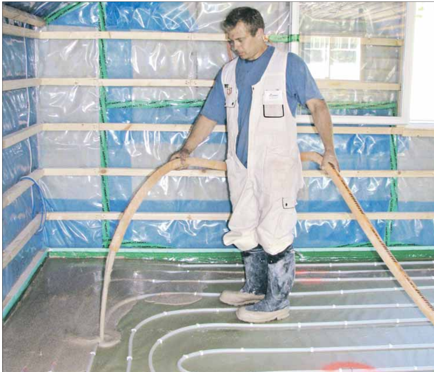
Jouni Kartaslammi sanoo, että pienyrittäjän kannattaa rakennusallalla pitää montaa rautaa tulesa ja laajentaa osaamistaan. Itse hän tekee sähkötöitä lukuun ottamatta melkein mitä tahansa rakentamiseen liittyvää. Kuva: JoKa-Remontit.
